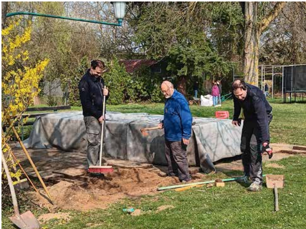
Arnulf begradigt mit seinem Team die Platten an der Sitzecke.
